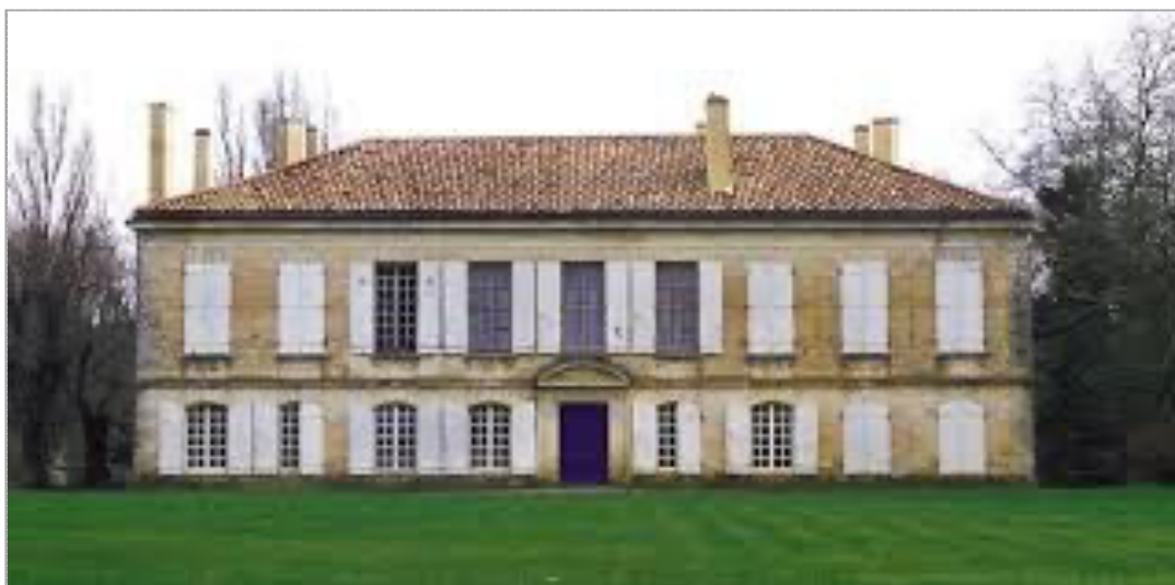
Le Château d'Arbanats
