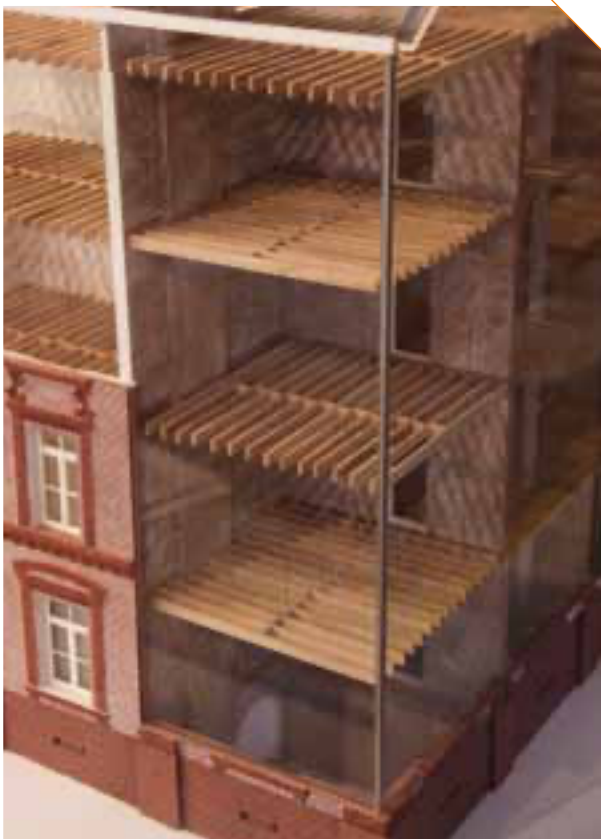
Sens alternés du solivage des planchers dans les angles de l'édifice.
