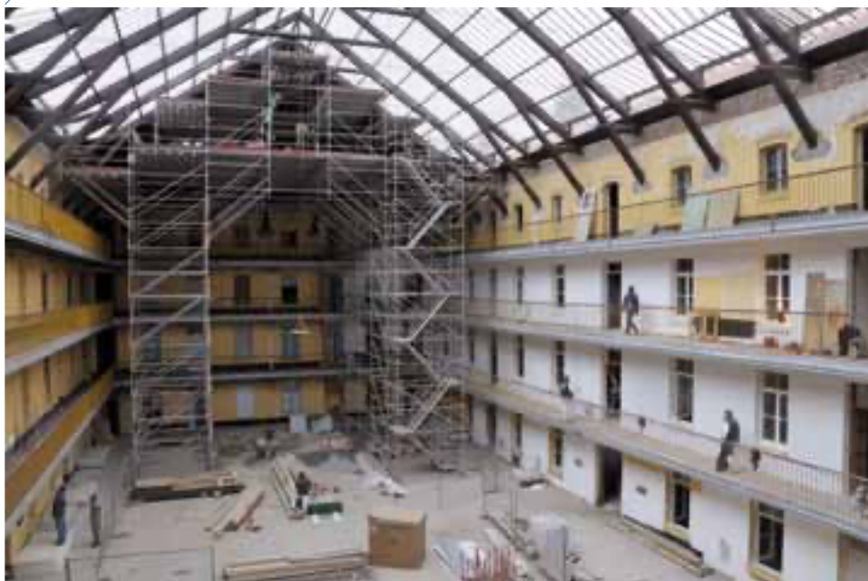
Chantier du pavillon central, 2009. Photographie Hugues Fontaine © Familistère de Guise
