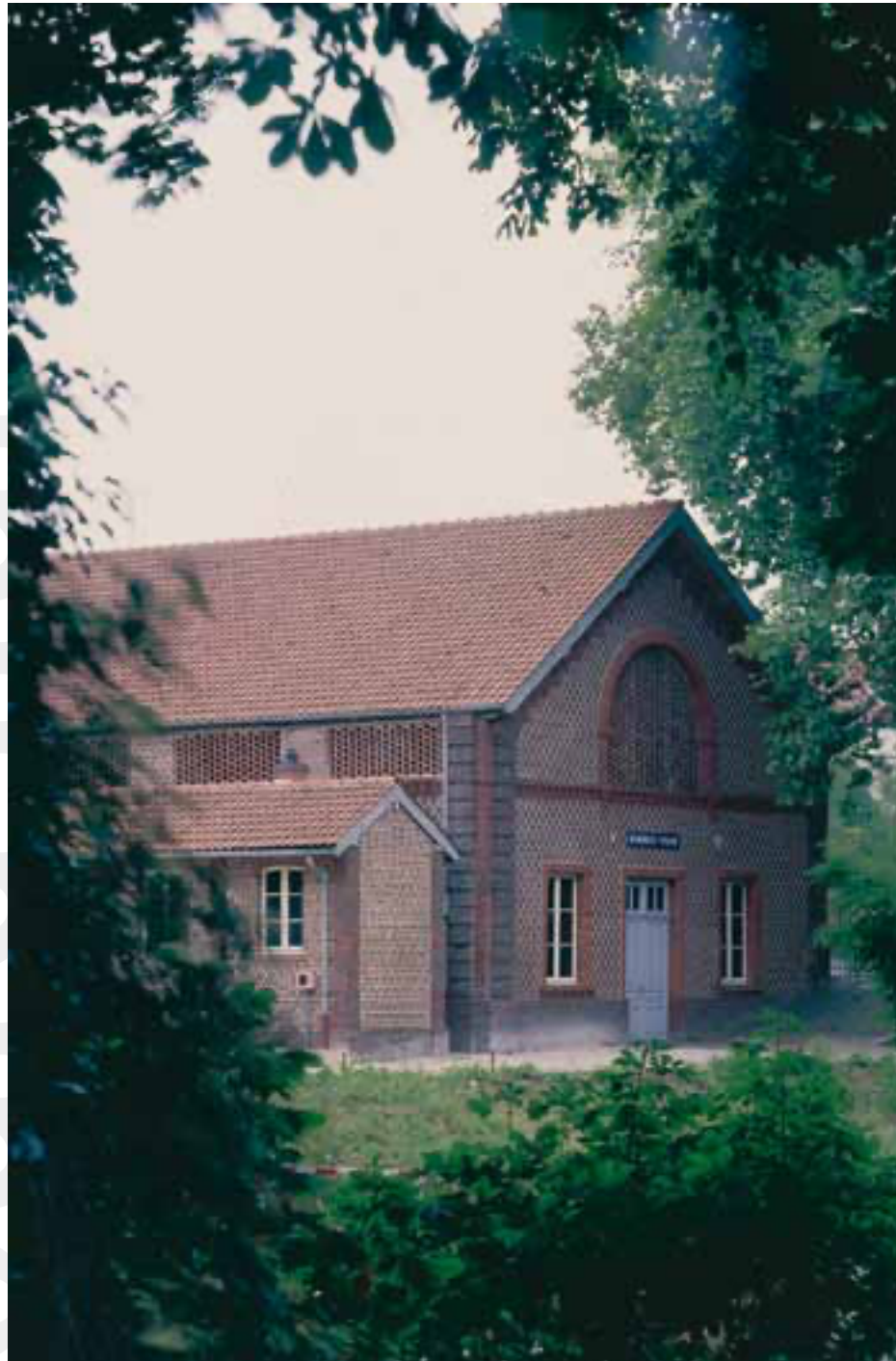
La buanderie-piscine. Photographie Georges Fessy, 2010. © Département de l'Aisne
