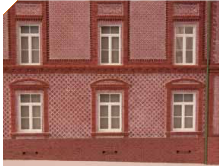
Le jointement des maçonneries de façade.
