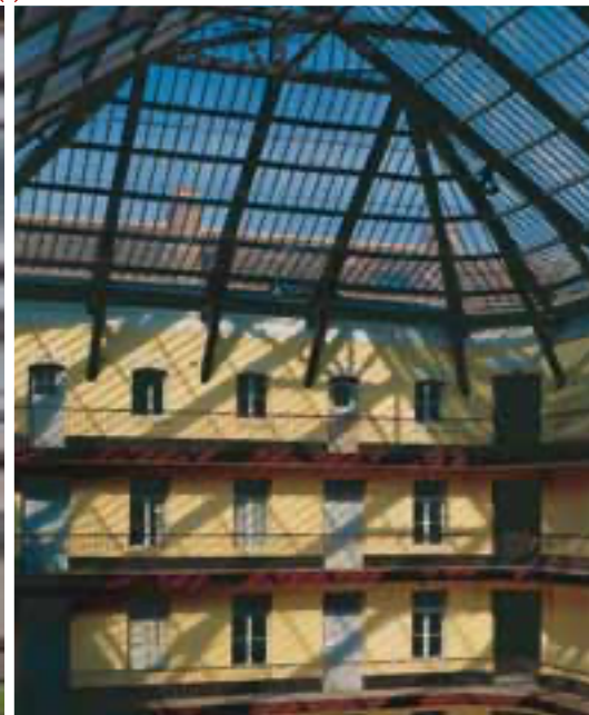
Cour du pavillon central du Familistère. Photographie Georges Fessy, 2010. © Département de l'Aisne
