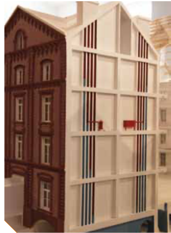
Les conduits de cheminée prennent naissance dans les caves.
