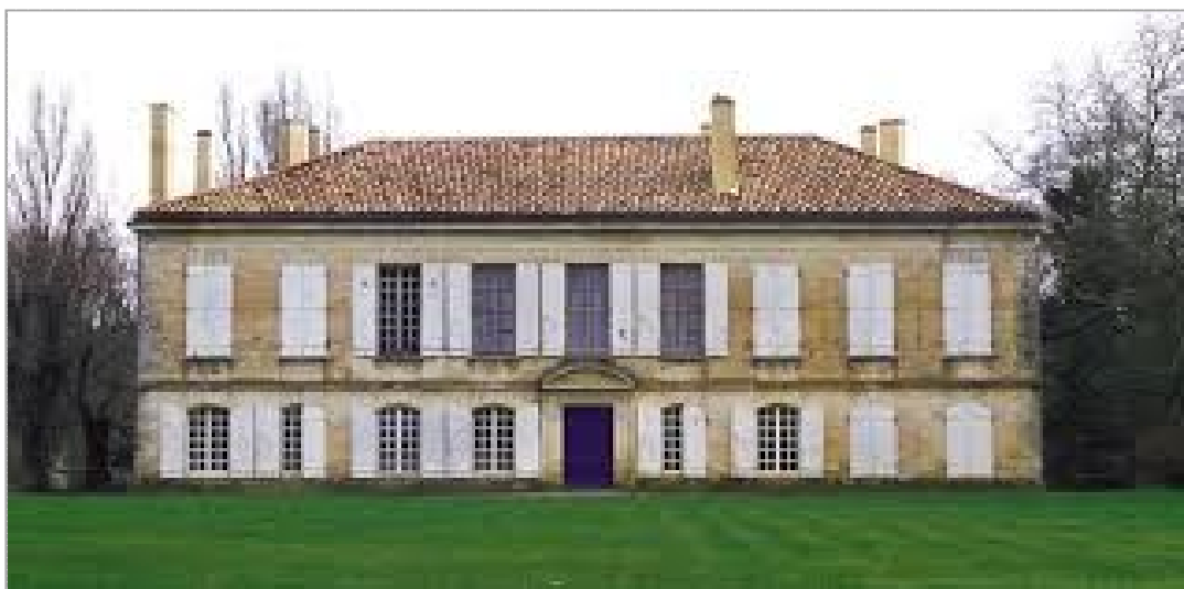
Le Château d'Arbanats
